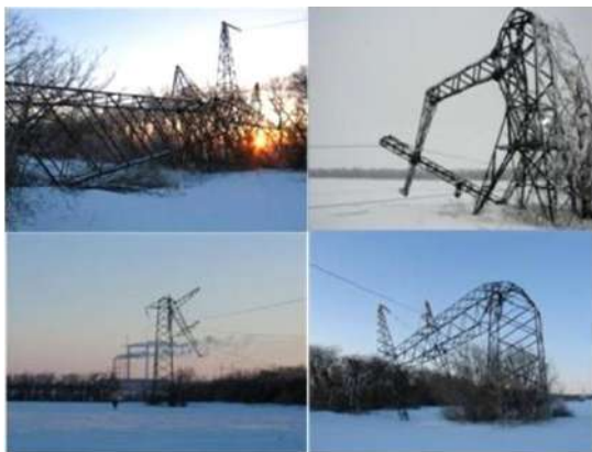
Рис.1 – Гололедные явления в Ростовэнерго
