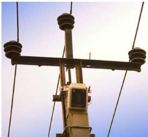
Рис.1. Установка ИКЗ-1 фирмы Антракс на высоковольтной опоре
