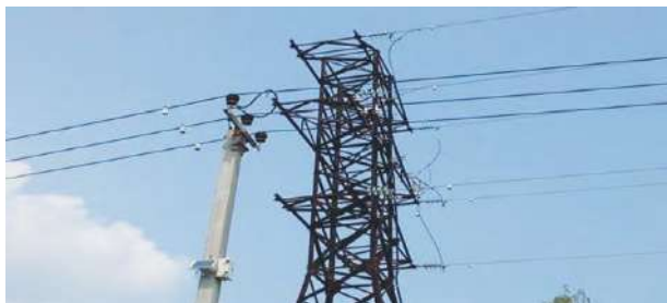
Рисунок 4 - Геоинформационная система на высоковольтной опоре
