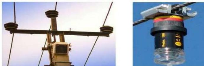
Рис.1 – Индикаторы повреждений Российского производства (слева) и иностранной фирмы (справа)
