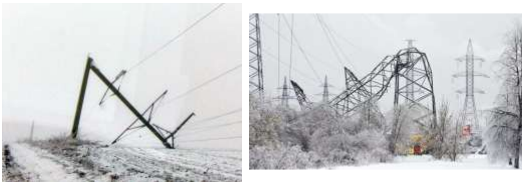
Рисунок 2 – Разрушения опор линии гололедом
