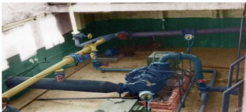
1 – всасывающие трубопроводы насосов; 2- напорный трубопровод смесителя.
