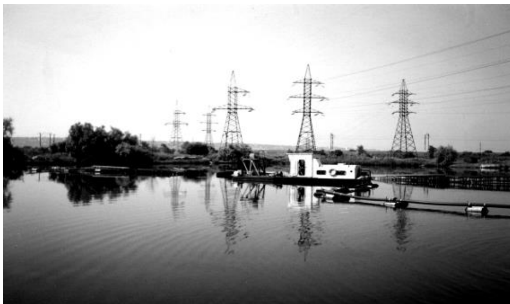
Рисунок 1 – Испытание эжекторно-землесосного снаряда на технологическом отстойнике новочеркасского электродного завода
