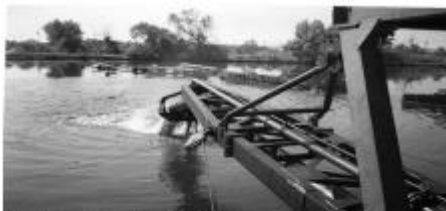
Рисунок 5 – Работа гидравлического рыхлителя
