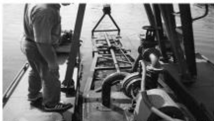
Рисунок 4 – Центробежный насос 4К-6 для подачи чистой воды в струйный насос
