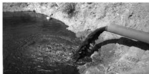
Рисунок 9 – Работа напорного пульпопровода
