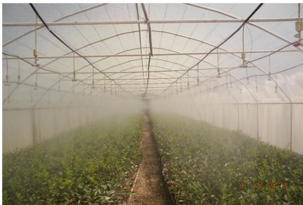
Рис. 3. Туманообразующая установка в действии.
